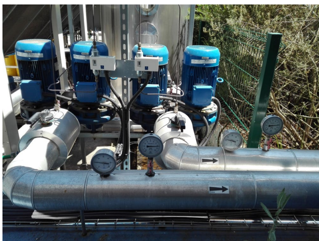
Obrázek 1: Čerpadla s proměnnými otáčkami
