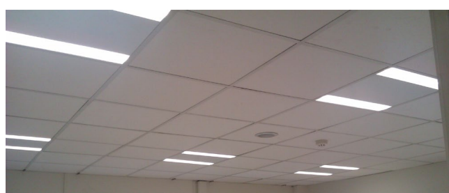
Obrázek 2: Svítidla se světly LED PO realizaci
