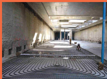
Kolektory položené do betonových základů stanic
