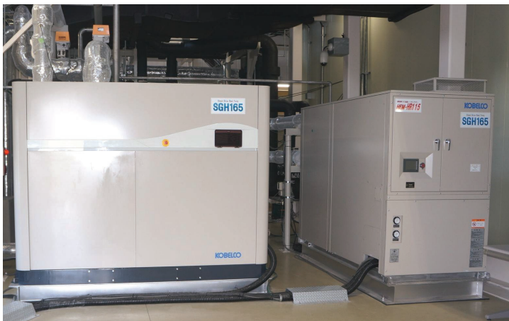
Obrázek 8: Model TČ SGH 165 s dodávkou tepla v podobě páry; vpravo tepelné čerpadlo, vlevo parní kompresor
