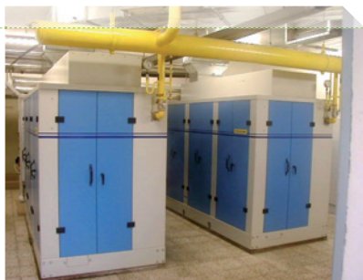
Zleva: Rozvody topné vody v kotelně, kogenerační jednotky a teplovodní kotle 3x MW v lázních Aurora
