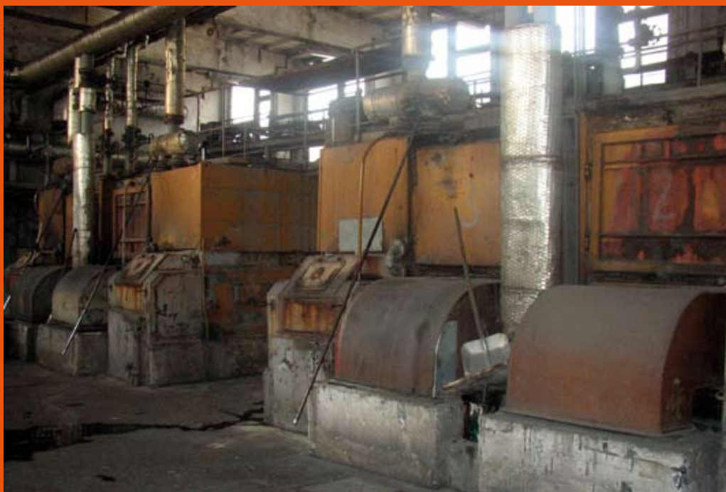
Horažďovice - kotelna před rekonstrukcí Horažďovice - boiler house before reconstruction
