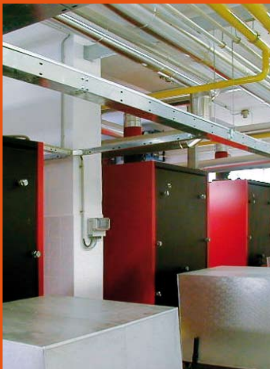
Plynové kotle v Lázních Aurora Boiler house Lázně Aurora
