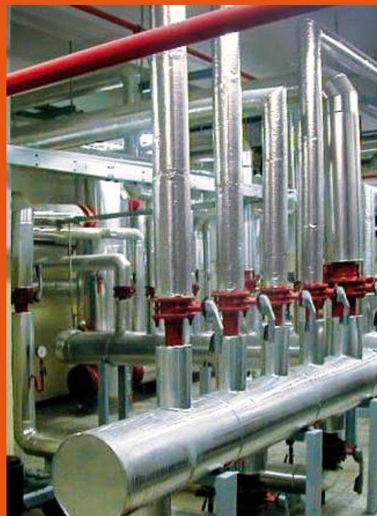
Strojovna kotelny Lázně Aurora Engine Hall of Boiler House Lázně Aurora
