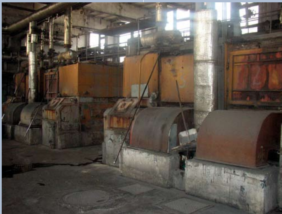
Horažďovice. Kotelna před rekonstrukcí Horažďovice. Boiler house before reconstruction
