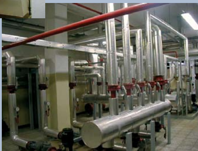
Strojovna kotelny Lázně Aurora Engine Hall of Boiler House Lázně Aurora
