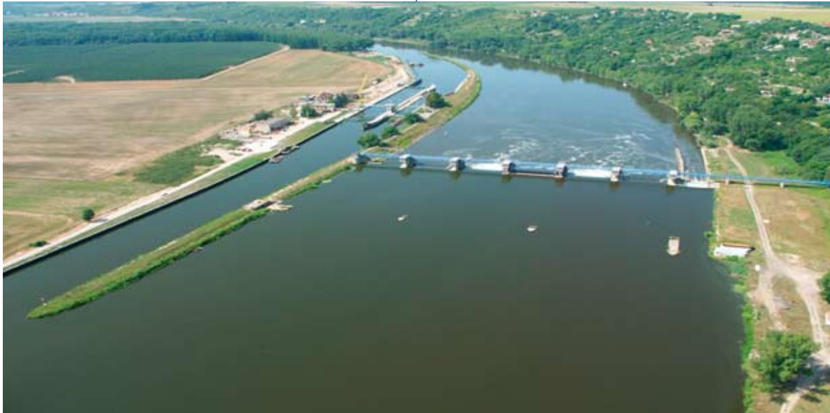
Malá vodní elektrárna Štětí Small Hydroelectric Plant in Štětí
